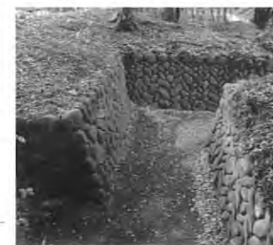
櫓台の横下方にある石垣の築手口。石垣は矢笄のような珍しい積み方。
