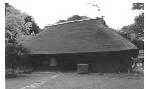
主屋。柱や梁などの材料の使い方や技法、工法などに、近世初期の古民家に見られる要素がすべて含まれている。1580年創建、1650年前後に改築。うまやを併せ持つ土間、広間、表座敷、奥座敷、裏座敷、納戸からなる。
